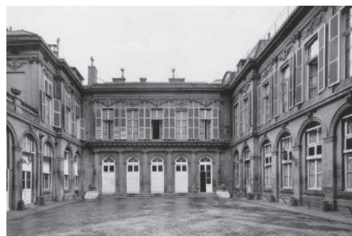
Vue de la cour intérieure de l'hôtel du baron de Baulny (précédemment hôtel Crozat)
